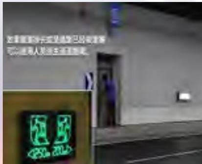
3. 卷帘门逃生：车行通道的防火门采用了卷帘门的形式，正常情况下处于关闭状态，紧急情况时可通过三种方式控制：一是在隧道中控室远程控制开启；二是在卷帘门处按动开启按钮自动打开；三是采用手动方式，按住把手用力向上提即可打开。卷帘门主要是在保证安全的情况下供汽车使用。
