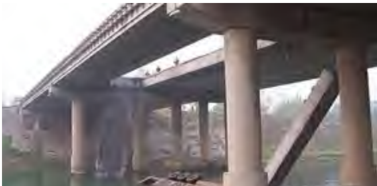
2009年漯河市南澧河大桥被260吨超载车压垮
