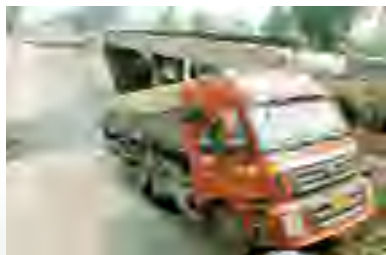
2007年太原东柳林桥被183.2吨超载车压垮
