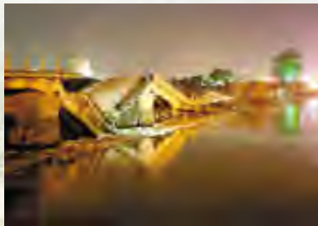
泉州 795 年历史的顺济老桥垮塌
