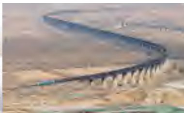
6 辆机车头牵引的两万吨煤炭重载列车通过永定河特大桥
