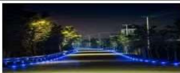
图 2-24 路边缘设置自发光突起路标，行车和行人双保障
