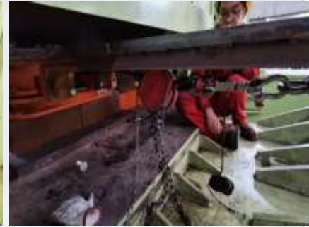
设置后端拉力设备并拉紧
