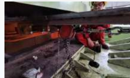
后端拉力设备卸载，调整块滑出
