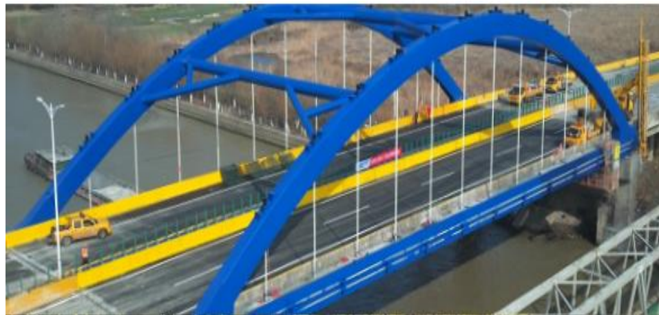
长兴吕山大桥（主跨77m）
