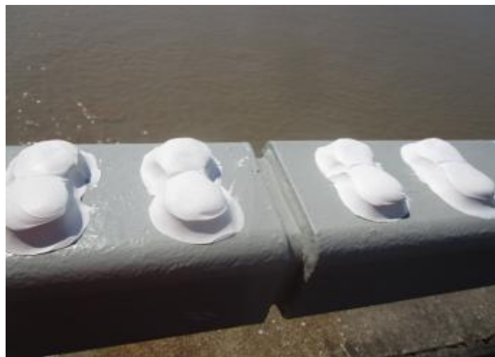
钢制螺栓防腐涂装实施后
