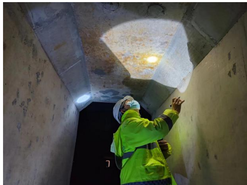
桥梁现场检查
