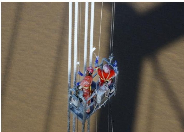
涂装实施过程
