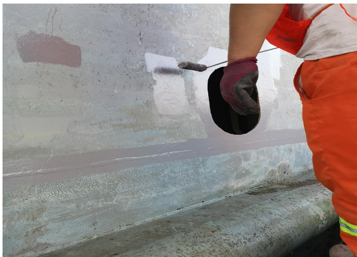
涂装实施过程
