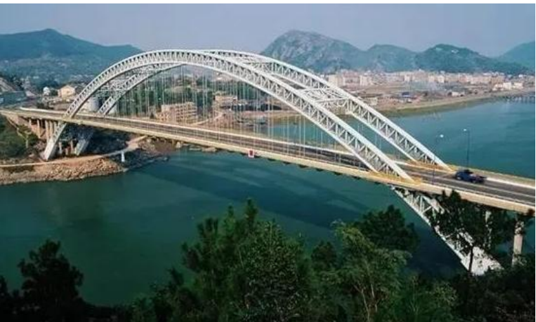
三门健跳大桥（主跨245m）
