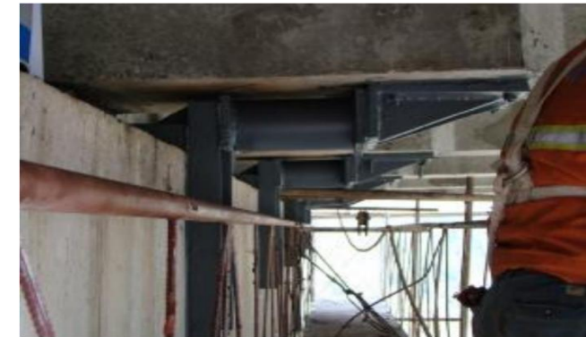
墩顶水平顶推
