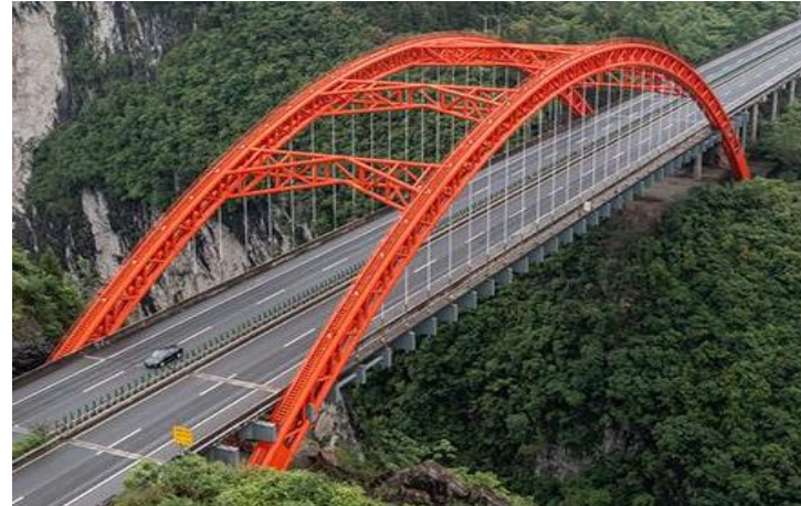
重庆细沙河特大桥（主跨190m）
