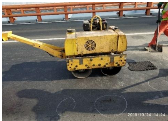
小范围坑槽、坑洞维修
