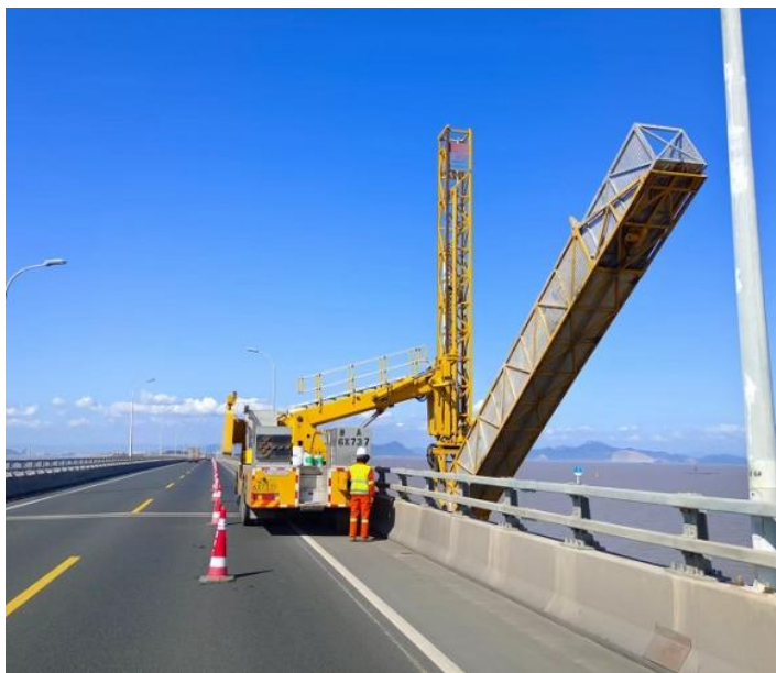
头门港大桥桥梁技术状况核查
