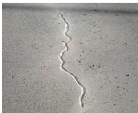
裂缝开槽
