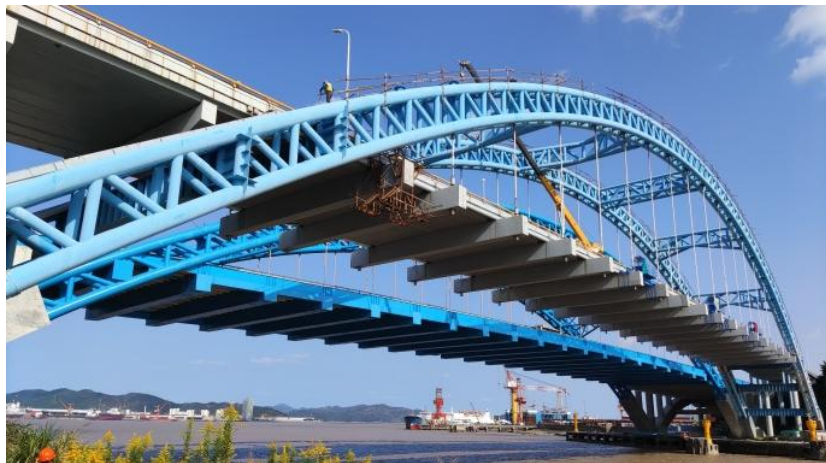
岱山江南大桥（主跨192m）
