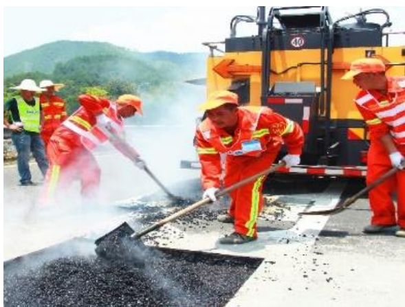
应急坑洞修补
